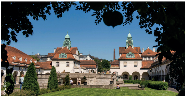
★ Sprudelhof, Bad Nauheim S. 38
